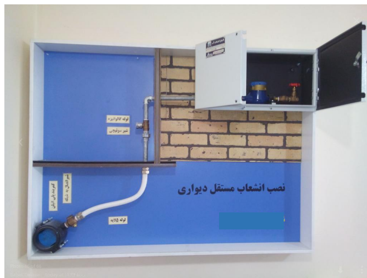
تصویر ۲- طرح شماتیک نصب کیت انشعاب با محفظه دیواری
