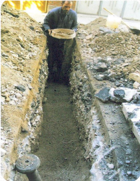
شکل ۷: پوشاندن مسیر انشعاب با خاک سرنندی
